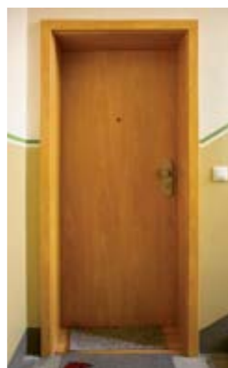
Jede Wohnung erhielt eine neue Wohnungstür der Brandschutzklasse T30 mit Obertürschließer ...
