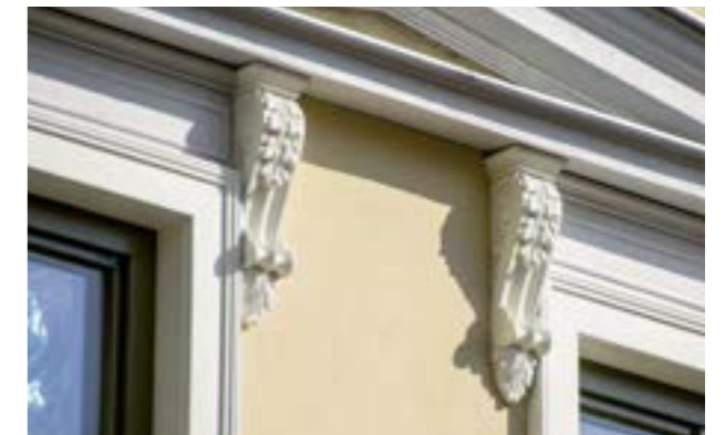
Die rekonstruierten Stuckelemente verleihen der Fassade ein besonderes Flair.
