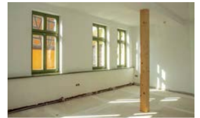
Stand Ende Oktober: Im November wurden hier die Fußböden verlegt und die Elektroinstallation komplettiert.
