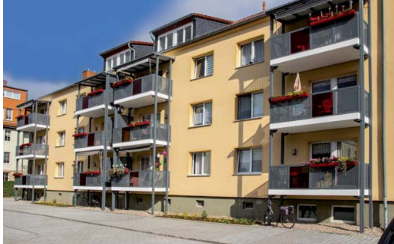
Mit der neuen Balkonanlage und den gepflasterten Hof mit einem Stellplatz für jeden Bewohner haben wir in diesem Jahr die Modernisierung sowohl des Gebäudes als auch des Wohnumfeldes abgeschlossen.
