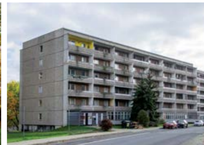
Nach der aktuellen Planung wird das Gebäude Paganinistraße 7–10 (Bild links) im kommenden Jahr vollständig zurückgebaut. Der Wohnraum des Objektes Erich-Correns-Ring 37 soll bis zum Sommer 2023 in einem ersten Schritt leergezogen werden.
