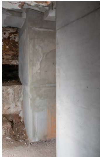
Drei neue Fundamente im Keller
