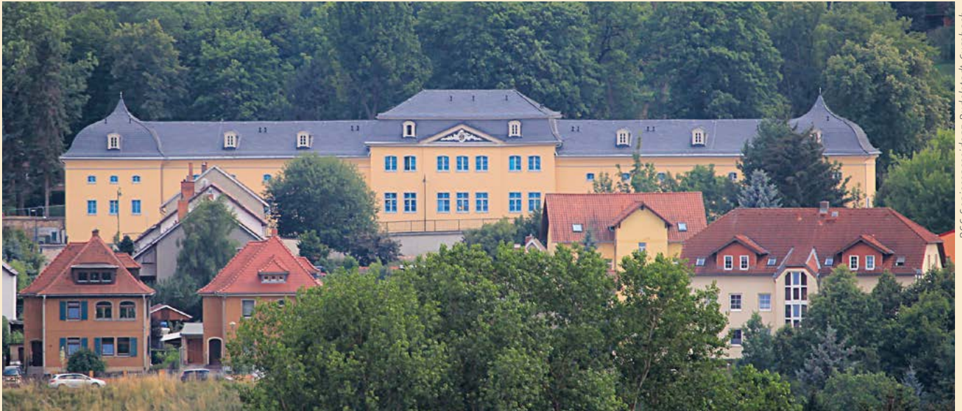
Die Nordseite des Gebäudes ist von der Heidecksburg aus gut zu erkennen.
