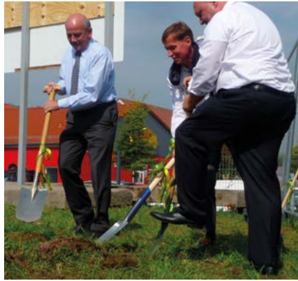
Im September 2014 startete Jens Adloff (Mitte) im Kreise seiner Mitstreiter den Neubau des Ärztehauses in Schwarza mit einem feierlichen Spatenstich.
