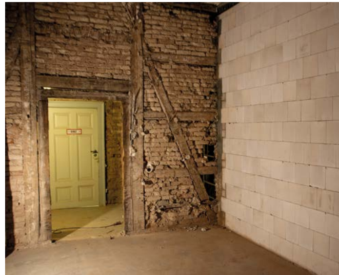
Aufgrund der Qualität des Baumaterials wurden und werden einige der inneren Wände komplett erneuert.
