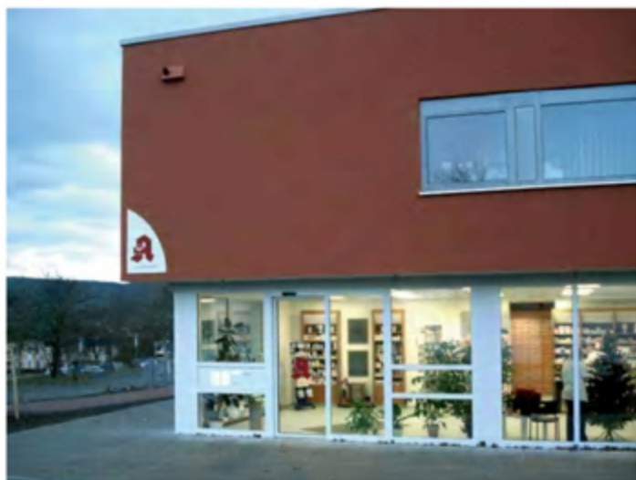
Ziel erreicht: Neues Ärztehaus in der Trommsdorffstraße sichert die medizinische Grundversorgung in Volkstedt-West.
