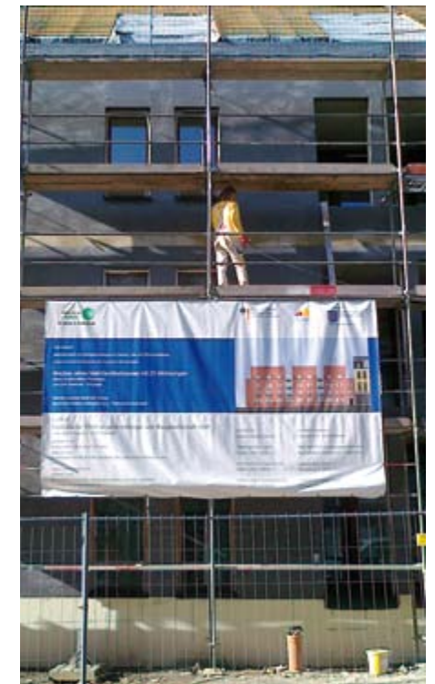
Demnächst werden die Gerüste fallen. Dann wird der Blick auf unseren Neubau frei.
