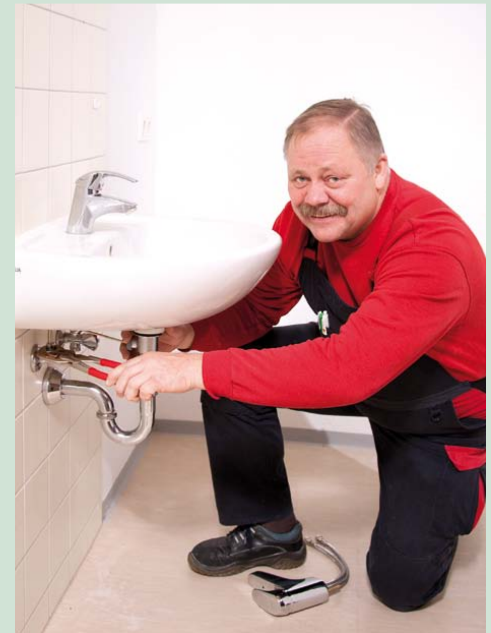
Der Austausch einer Mischbatterie gehört definitiv nicht zu den Havarien. Repariert wird sie von unserem Hauswart Hans-Günther Ball während der Servicezeiten trotzdem.
