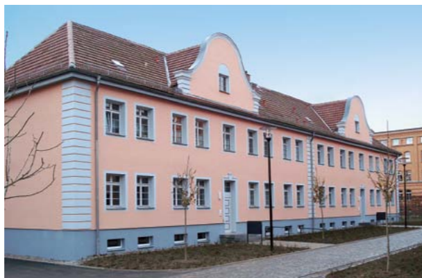
Eines der wichtigsten Bauprojekte war 2008–2009 der Umbau des Denkmalensembles der ehemaligen Kasernen in der Schwarzburger Chaussee 32–48. In vier Gebäuden entstanden 36 moderne Wohnungen.
