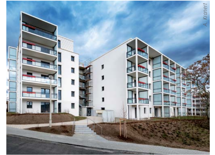
Die weit aus der Ferne gut sichtbaren Gebäude in der Paganinistraße 2–10 wurden 2017 grundhaft modernisiert und u. a. mit großzügigen Balkonen in der Art der sogenannten Ostseearchitektur umgebaut.
