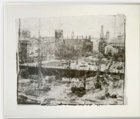
Das Werk „Schlossbaustelle Berlin 2013“ mutet wie die Bilder zu Beginn der Fotografie an, obwohl es eine Momentaufnahme aus der heutigen Zeit ist.
