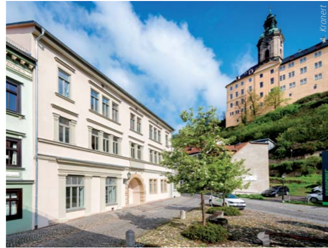
In der Innenstadt wurde 2016 das historische Gebäudeensemble Vorwerksgasse 13/Stiftsgasse 27 mit acht modernen Wohnungen stilgerecht erneuert.
