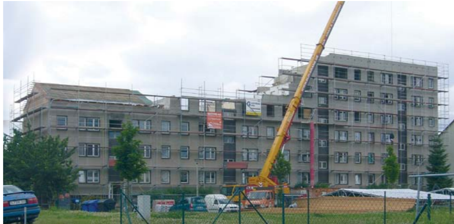
Ab 2008 realisierte die RUWO erstmals Teilabriss von Gebäuden. Die oberen Etagen wurden zurückgebaut, die unteren grundhaft modernisiert, wie beim Objekt Breitscheidstraße 117-123.
