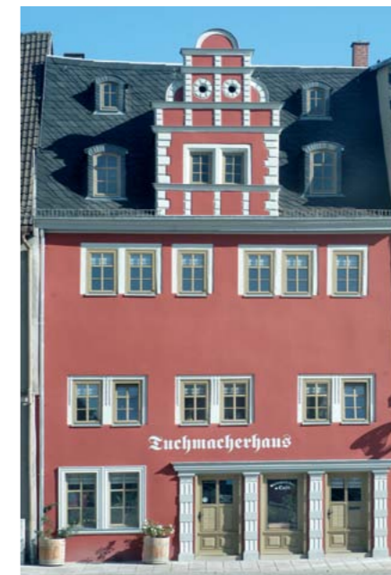
Die historische Fassade der Gaststätte „Tuchmacherhaus“ am Markt 9 erstrahlte 2005 in restauriertem Glanz.
