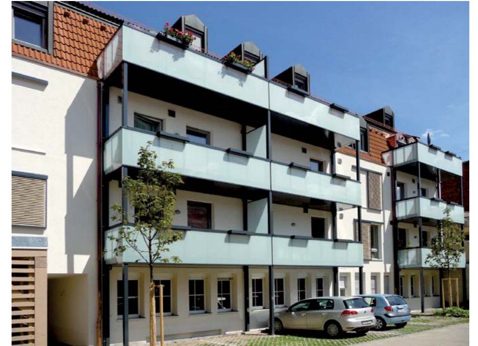
Nach der Modernisierung des Wohn- und Geschäftshauses Mangelgasse 7 konnten im Mai 2011 insgesamt 17 moderne Wohnungen in der Innenstadt mit anspruchsvoller Ausstattung übergeben werden.
