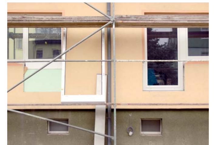
An der Fassade bereiteten die Fensterbauer bereits den Anbau der Balkonanlage vor, indem sie an der Stelle eines Wohnzimmerfensters eine Balkontür einbauten.
