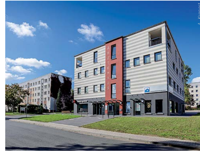
Im Stadtteil Schwarza-Nord entstand mit dem Ärztehaus in der Neuen Schulstraße 59a ein weiterer Neubau zur Verbesserung der medizinischen Versorgung. Die Wärmeversorgung erfolgte per Geothermie.
