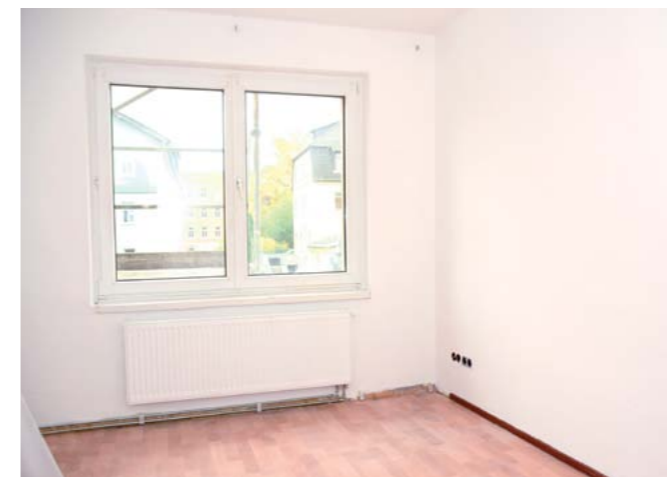
Ende Oktober strahlten die neuen Heizkörper bereits eine wohlige Wärme aus. Lediglich die Scheuerleisten und die Abdeckungen bei Steckdosen und Schaltern mussten noch angebracht werden.
