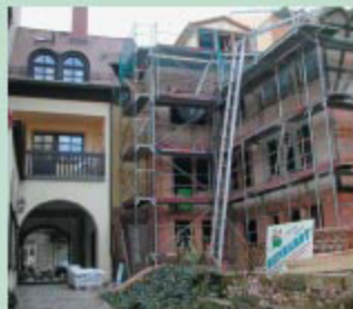
Aus Alt wird Neu: Mangelgasse 20
